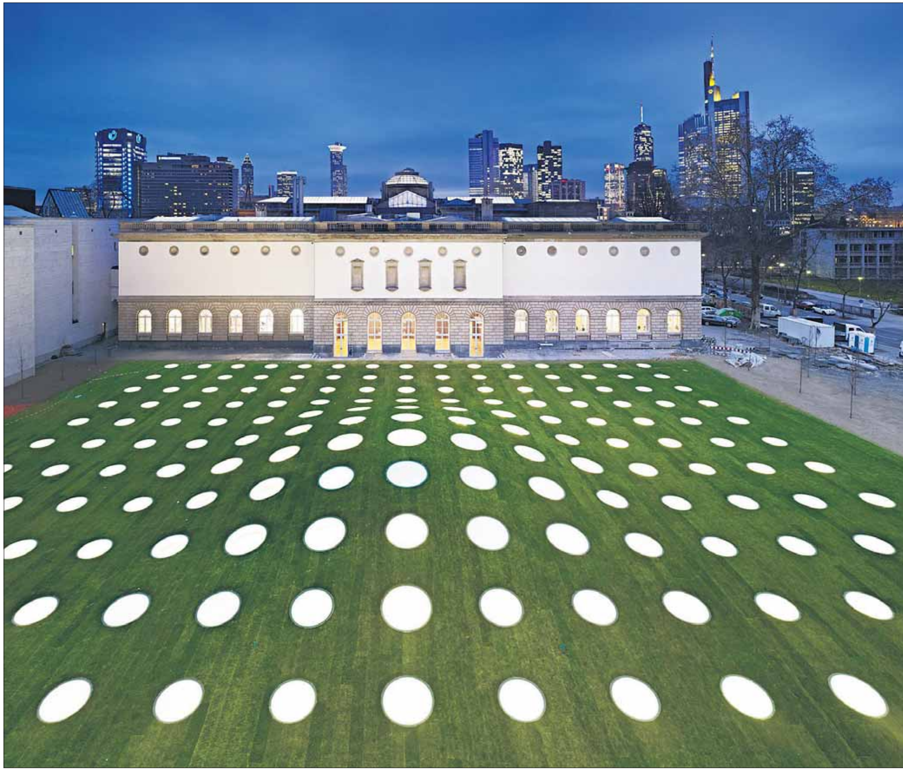
Keine Fassade: 195 Bullaugen sind alles, was von den 3000 Quadratmeter großen Gartenhallen des Museums Städel zu sehen ist, in denen künftig die Sammlung zeitgenössischer Kunst präsentiert wird. Abb: Foto: Norbert Miguletz / Städel Museum, Frankfurt am Main
