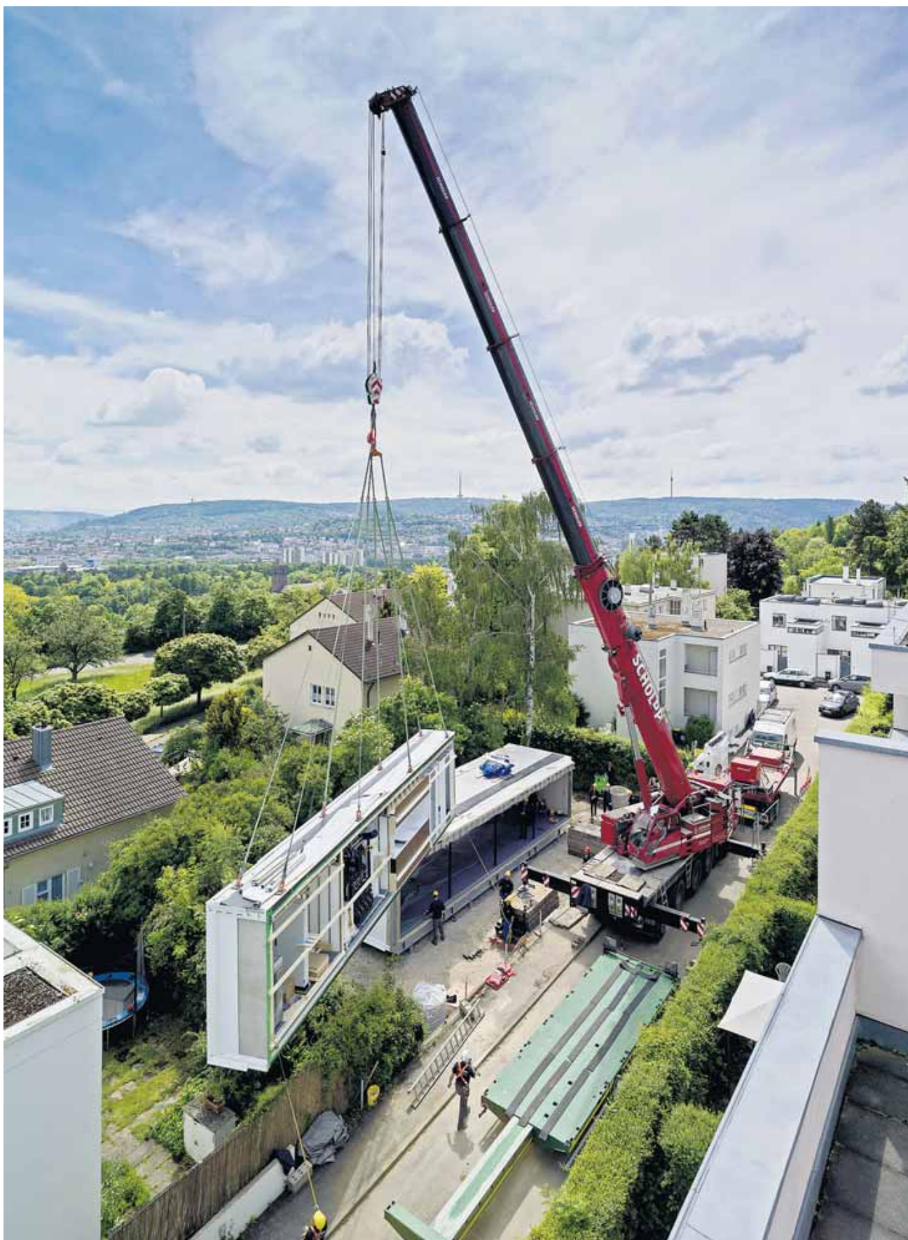
Fertighaus der Zukunft: Innerhalb von nur 24 Stunden war der von der Firma Schwörer-Haus realisierte Bau an Ort und Stelle. 85 Quadratmeter Wohnfläche werden nun von einem selbstlernenden Gebäudesystem gemanagt. FOTO: ZOOEY BRAUN
